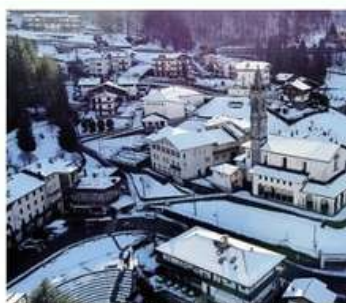
Gli alloggi di housing sociale accanto alla chiesa parrocchiale
